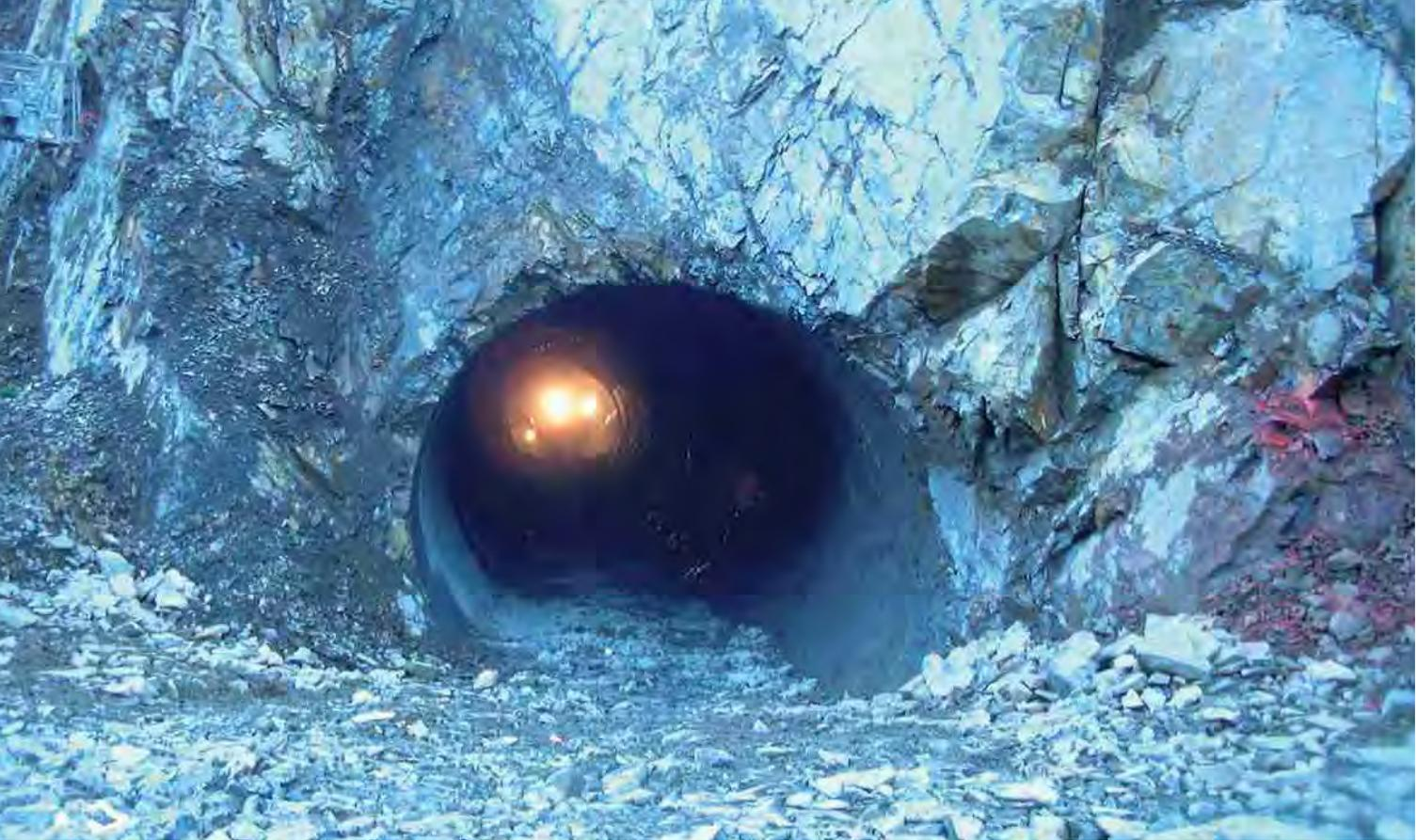
excessives. Aquests trams van requerir l'aplicació d'un sosteniment format per bulons, malla electrosoldada, formigó projectat i encavallades en els trams més conflictius.
