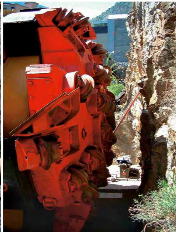
Un cop acabada l'excavació de la galeria pilot es va procedir a retirar la tuneladora pel seu interior fins a la parcel·la exterior de la boca Sud fent el recorregut invers.
