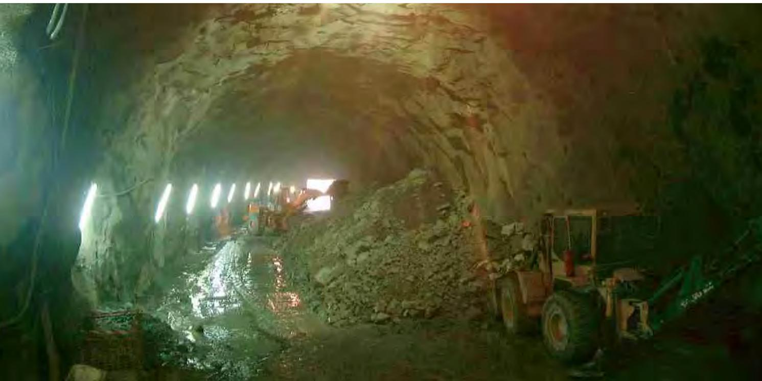
permetent el pas de camions. Finalment es va construir un portal de protecció a la boca Sud amb la funció de mitigar els efectes de l'ona aèria a l'exterior. Un cop va finalitzar aquesta fase complexa de l'excavació de l'entorn de la boca, es va prosseguir amb l'execució del túnel vers el Nord mitjançant avanços amb voladures de 3 i 4 metres. Es van utilitzar principalment detonadors electrònics, de major precisió per reduir l'efecte de les voladures.
